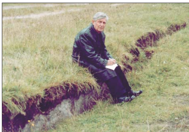
Трещина в водонасыщенных грунтах вдоль обрыва к искусственному водоему в пос.Веселовка ( I = 6 баллов).
