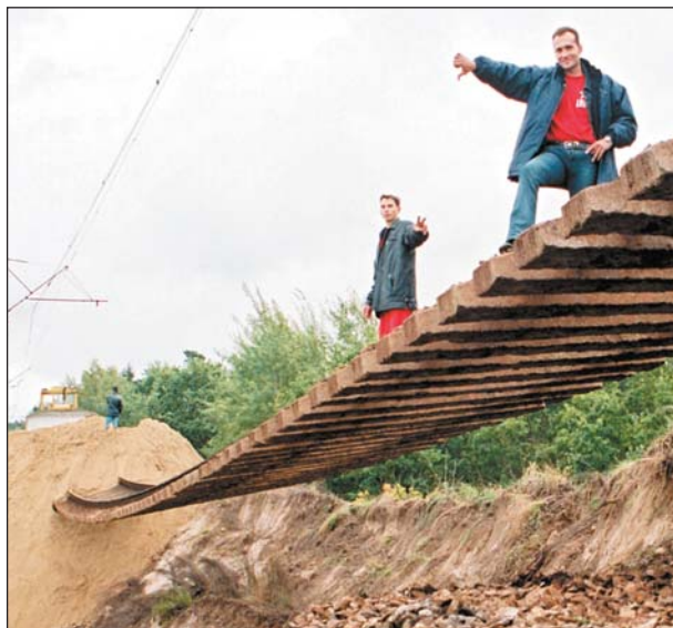
Сползание после второго толчка высокой насыпи под железнодорожным полотном ( I = 6 баллов).
