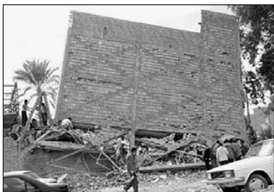
Разрушенный дом в г. Баме.
